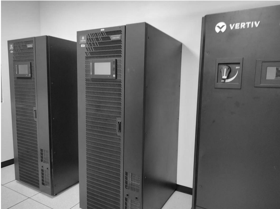
La imagen muestra centros de carga y transfer switches redundantes los cuales alimentan los UPS con energia de la red publica o de los generadores en caso de falla de CFE
